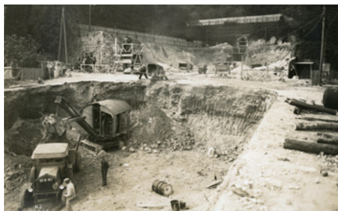
Construction du tube nord du tunnel
