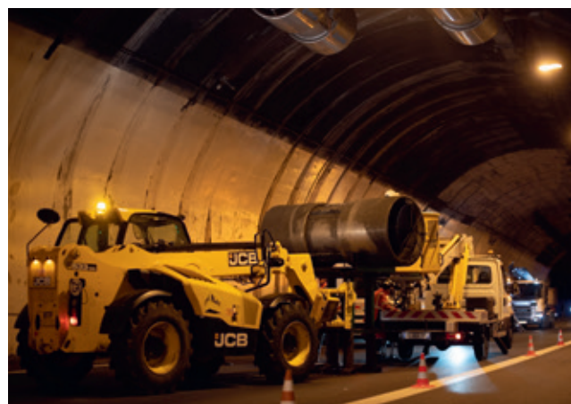
Inspection réglementaire du tunnel de 2024
