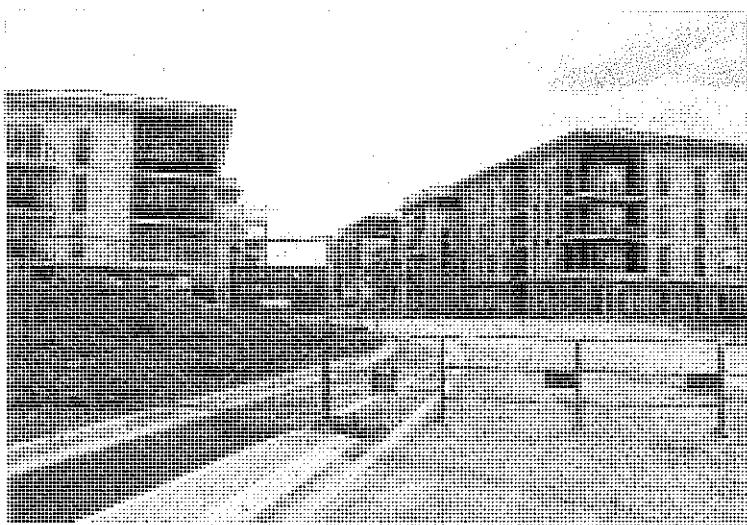
La maison médicale verra le jour dans le nouveau quartier des Hauts du moulin, actuellement en pleine construction.
